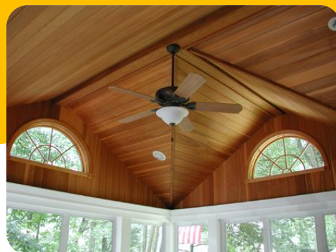
proteção de forro
